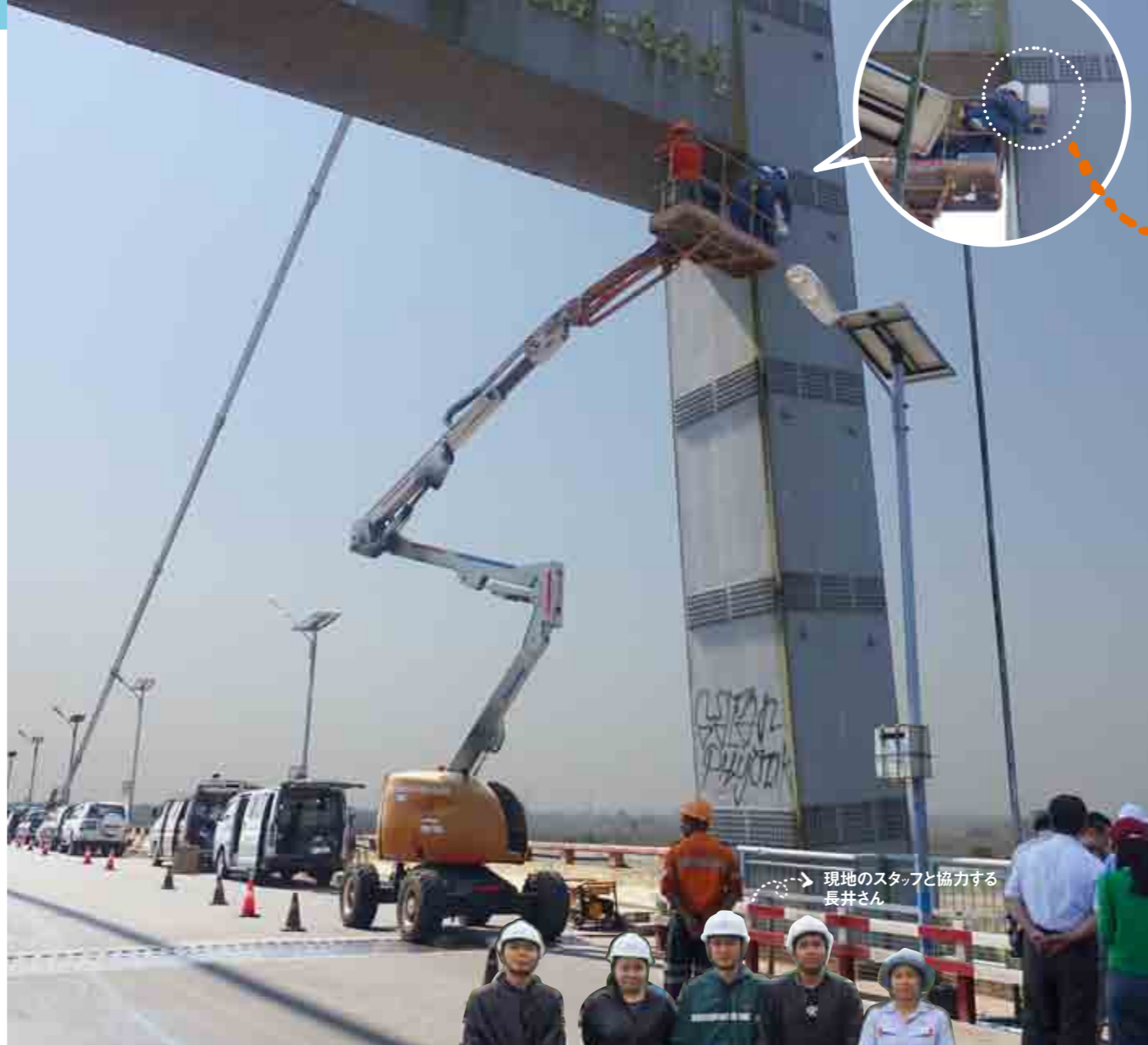
トンテイ橋のアンカー部分。定着部付近に滞水が確認された。トンテイ橋のアンカーには腐食は見られないが、今後を考え、溜まった水を排出できるような対策が必要と提案した。
