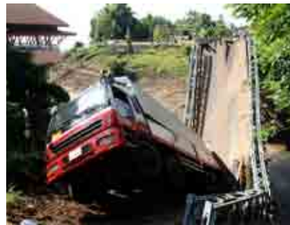
過積載トラックによって路面は削られ、橋梁の崩落などが起こった。写真はチャンバサック県で起こった崩落。
