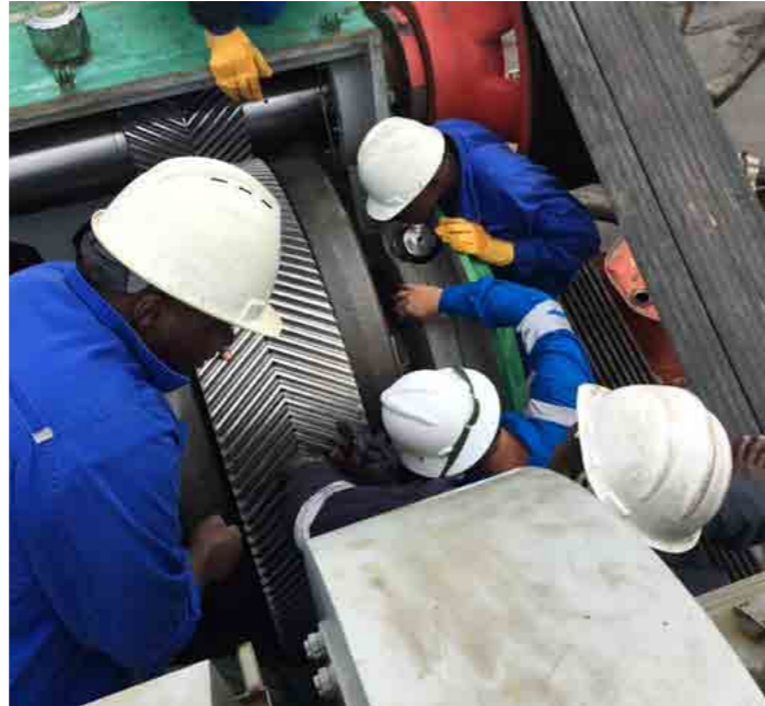
掘削技術を習得するための研修。事故を起こさずに安全を確保して作業する環境づくりも伝える。
