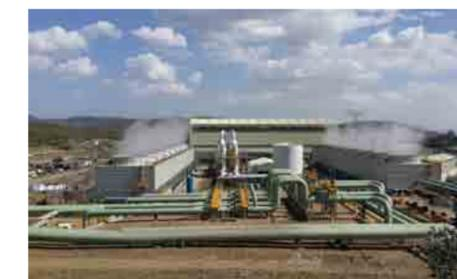
オルカリアI地熱発電所の4・5号機。オルカリア地域では、現在4つの地熱発電所で14基の地熱発電機が稼働中。うち10基に日本メーカーのタービンが使用されている。
