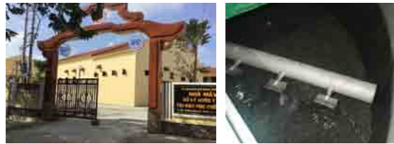
左：下水処理場の外観。世界遺産となった町の景観に配慮した洒落な造りだ。右：有機物を分解する散水ろ床。高い性能を持つ。
