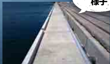
復旧された3B岸壁。5月には最新の防舷材や係船柱が設置されて船が安全に接岸できるようになった。
