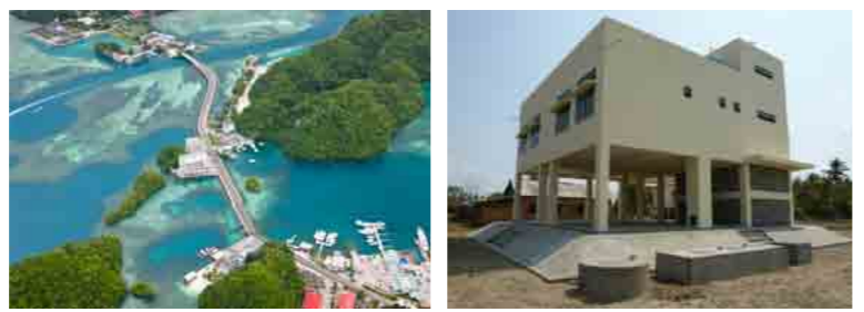
左：パラオの首都があるコロール島とマラカル島を結ぶ堤防道路には上下水道や送電線・通信線が併設されている。老朽化していて、高潮や台風などによる崩壊が懸念されていたが、日本の協力による改修によって安全性が確保された。右：気候変動の影響で台風の被害も大きくなる傾向にある。ミャンマーでは、台風にも強い校舎の建設を支援した (ともに写真提供：JICA)。
