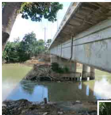
上：橋脚は川の流れに影響をおよぼしう る。橋脚に引っかった流木が水の流れ を妨げている。右：現在は基礎調査として、 河川・地形の測量、雨量解析などの データ集めや、住民への聞き取りが行わ れている。
