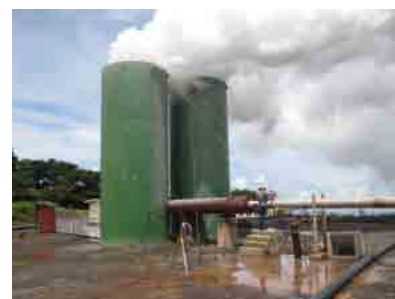
ラス・パイラス2の掘削現場。地下深部から熱水や蒸気を取り出し、発電のエネルギー源として使う。
