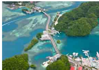
左：パラオの首都があるコロール島とマラカル島を結ぶ堤防道路には上下水道や送電線・通信線が併設されている。老朽化していて、高潮や台風などによる崩壊が懸念されていたが、日本の協力による改修によって安全性が確保された。右：気候変動の影響で台風の被害も大きくなる傾向にある。ミャンマーでは、台風に近い校舎の建設を支援した（ともに写真提供：JICA）。
