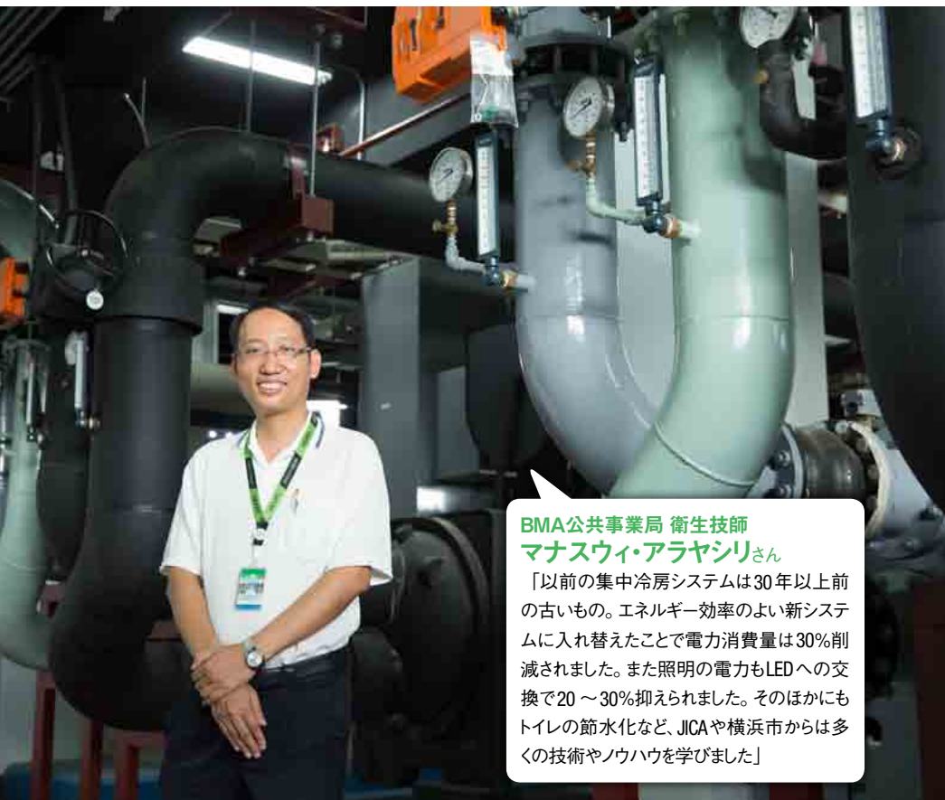
庁舎のリノベーション責任者であるアラヤシリさん。後ろにあるのは、新たに導入された高効率の集中冷房システム。
