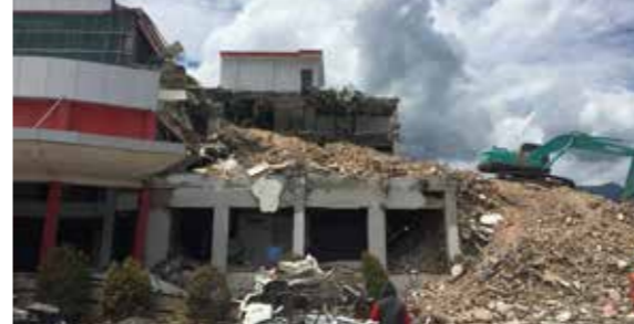
耐震性が不十分であったために地震で一部倒壊したバル市の公立病院。現在は整地されており、再建に向けた計画が進められている。
