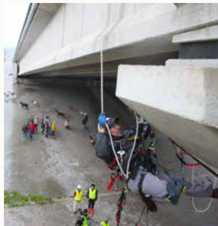
モロッコの橋梁での実務訓練。
