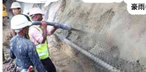
現場では日本人1人とスリランカ人作業員4人がチームを組み、現場1か所あたり5〜15人ほどの態勢で工事を進めた。
