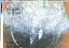
左：下水管の損傷により、水が溢れ出しているクアラルンプールの道路。右：損傷の原因の一つは木の根の侵入。写真は下水管の中に入り込んだ木の根の様子。
