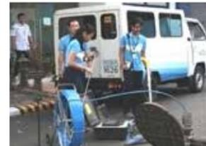
水道管の漏水箇所を特定するデモンストラーション。
