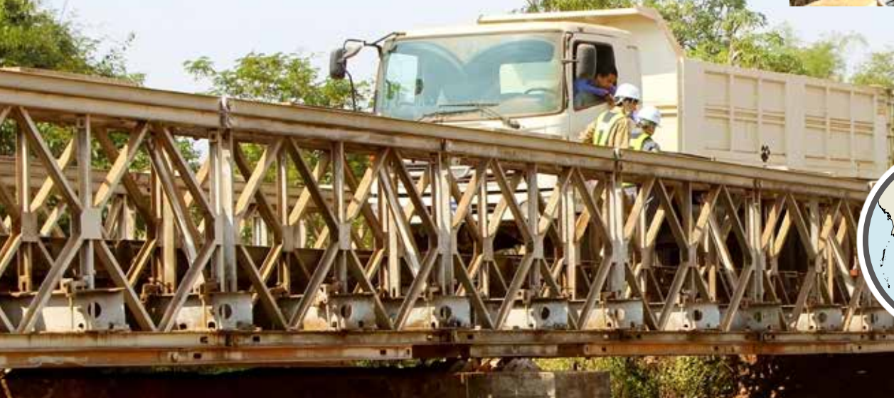
上・左：長崎大学総合生産科学域(工学系)准教授の西川さんが、ラオスのベイリー橋の実態を調査するために行った実験や計測。
