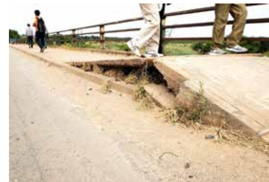
左：歩道部分が隆起しているザンビアの橋。このまま放置すれば、橋本体を傷めることになる。
