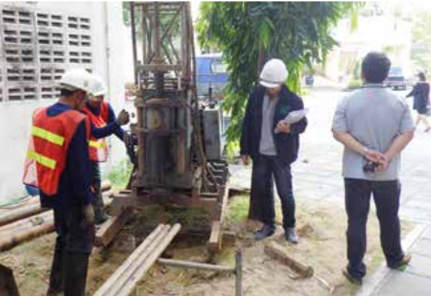
バンコクは地下水位が高く、地盤は粘土質。埋設工事前は慎重にボーリング調査を行った。
