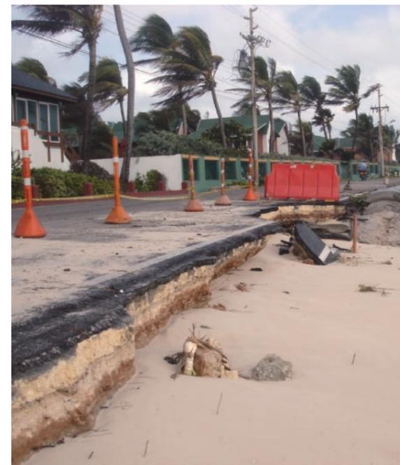
砂浜の侵食が進んだことで高波が道路にまで達し、建物が破壊されることもある
