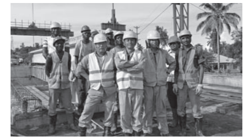
タンザニアで安全重視の道路工事を指導する日本人技術者 (撮影：久野武志)
