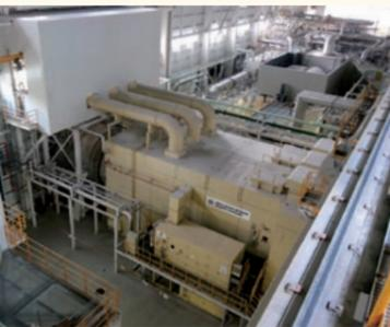
CCPPの中核となるガスタービン。ウズベキスタンでガスタービンを利用してつくられている電力の半分以上は、三菱日立パワーシステムズ製の設備による発電だ(発電設備容量ベース)
