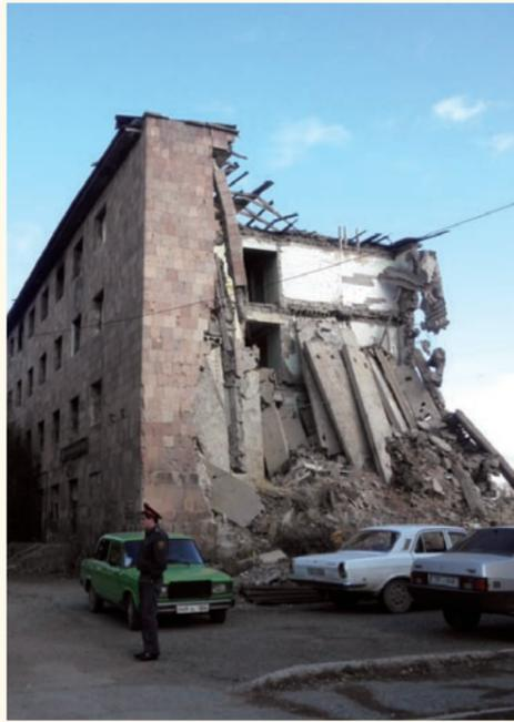
アルメニア・ギュムリ市内に残る、1988年のスピタク地震で倒壊した住宅。危険な状態にもかかわらず、建物の一部には今も数世帯が居住している（2011年11月撮影）
