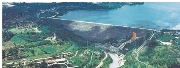
カランカテスダム (Photo: 日本工営株式会社)
