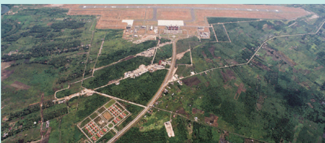
パダン空港と空港アクセス道路全景 (Photo: Lukman F. Laisa)
