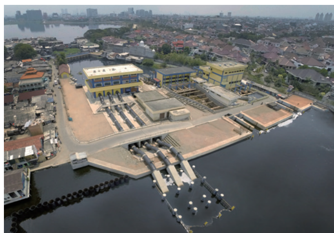
ブルイット排水機場 (Photo: JICA)
