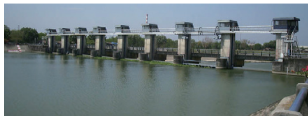
ブラントス川最下流域への水配分の要、新レンコンダム (Photo: 日本工営株式会社)
