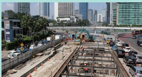
ホテルインドネシア前ロータリー駅付近の工事
