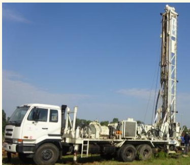
井戸を掘る掘削機
