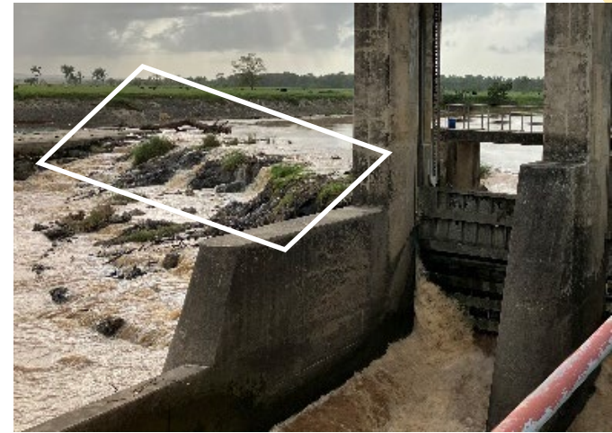
対象候補地区の取水地点。 洪水吐きゲートの右岸側（写真左、白枠部分）にはかつてゴム製の可動堰が設置されていたが、破損により今は見る影もない。
