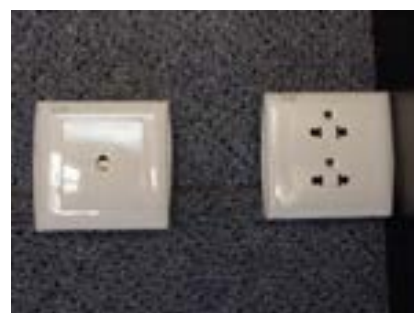
コンセント(向かって右。二相丸ピン・二相平型両タイプのプラグに使える)とモジュージャック(同左)
