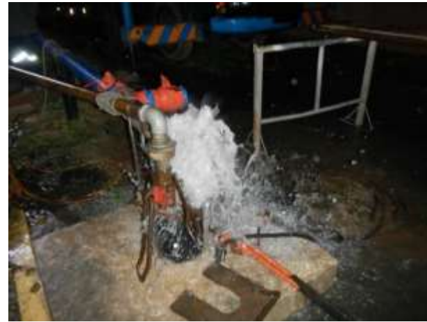
診断結果から改修方法を選定。 改修作業（洗浄）を実施。
