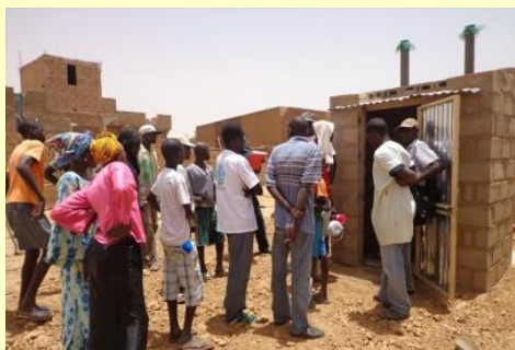
建設されたトイレの仮引渡し (マタム州マニヤム・バラナベ村(2014.04))
