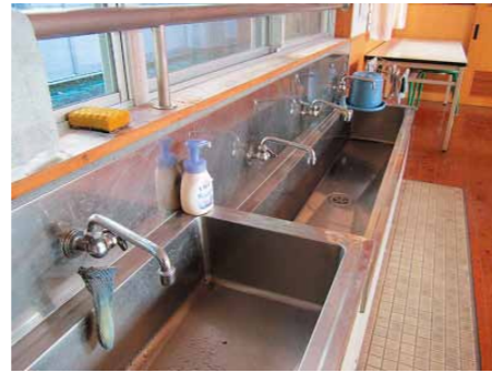
七里小学校内 水道
