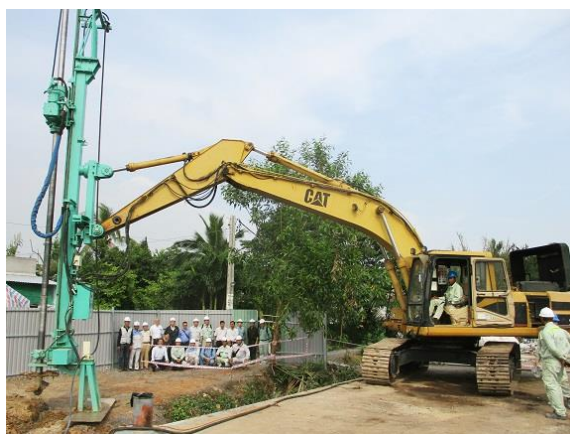
ベトナムにおける機材実証試験の様子
