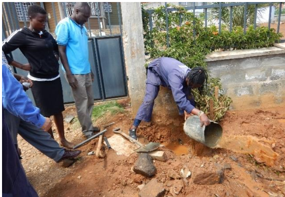
ケニアの漏水状況
