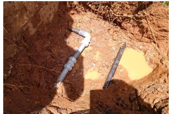
管継手活用の様子
