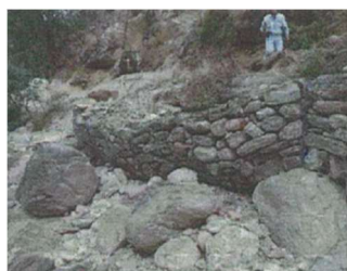
品質が劣り機能が失われた蛇籠護岸 (ネパール国スコンシ川)
