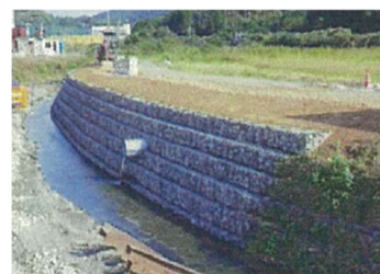
中小河川に整備された蛇籠護岸(高知県の町、南ノ川)
