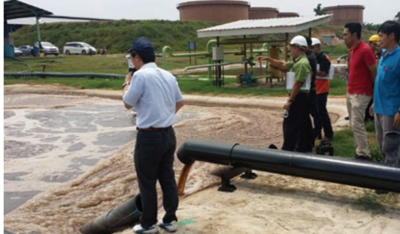
反応槽にパームオイル工場の排水を流入させ、実証試験を開始。アクアレータは適切に運転管理されれば、排水中のBOD値を500mg/Lから20mg/L以下にまで低減させることができる。
