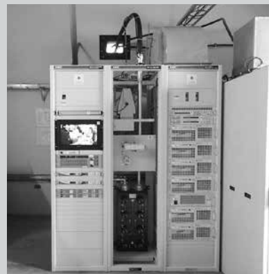
Equipos de transmisión digital para el sistema de WEBS (Foto: cortesía de Yachiyo Engineering Co., Ltd.).
