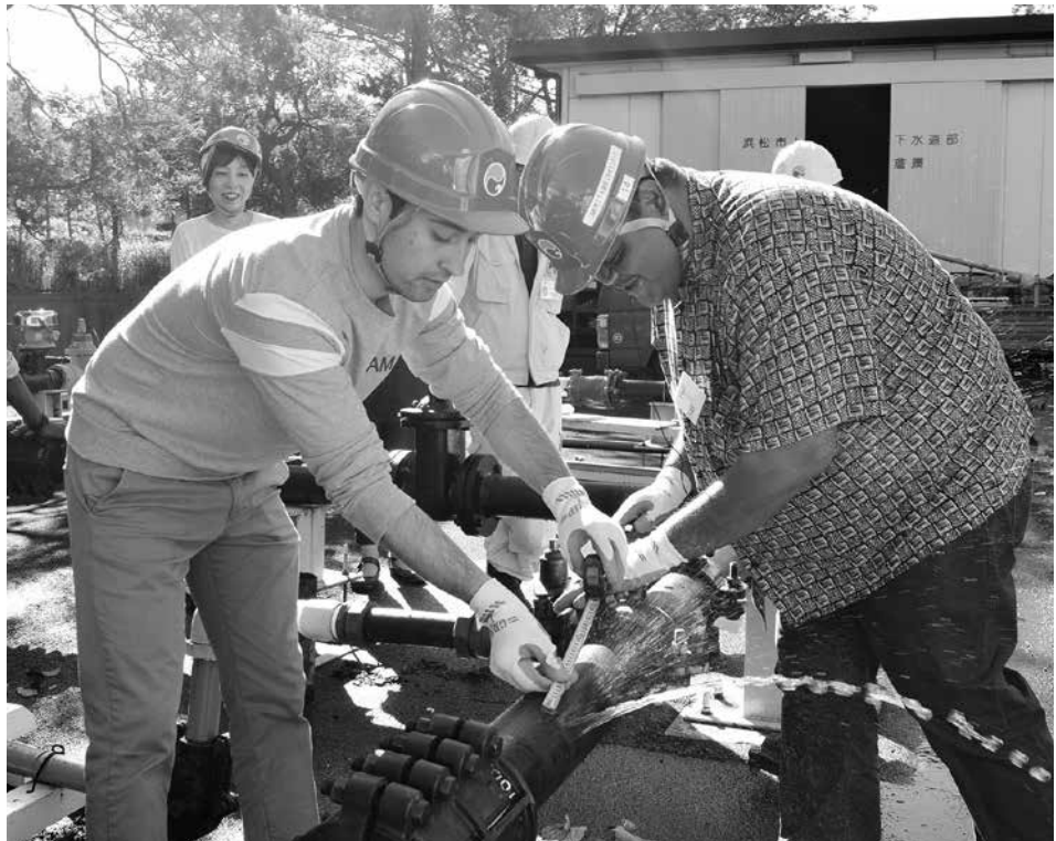
Los participantes de un Curso de Capacitación en Japón aprenden la reparación de fugas de agua en el Centro de Capacitación, en la ciudad de Hamamatsu, Shizuoka. (Curso Colectivo de Capacitación por Tema: Manejo del agua no remunerada (Medidas de control de fugas de agua)).
