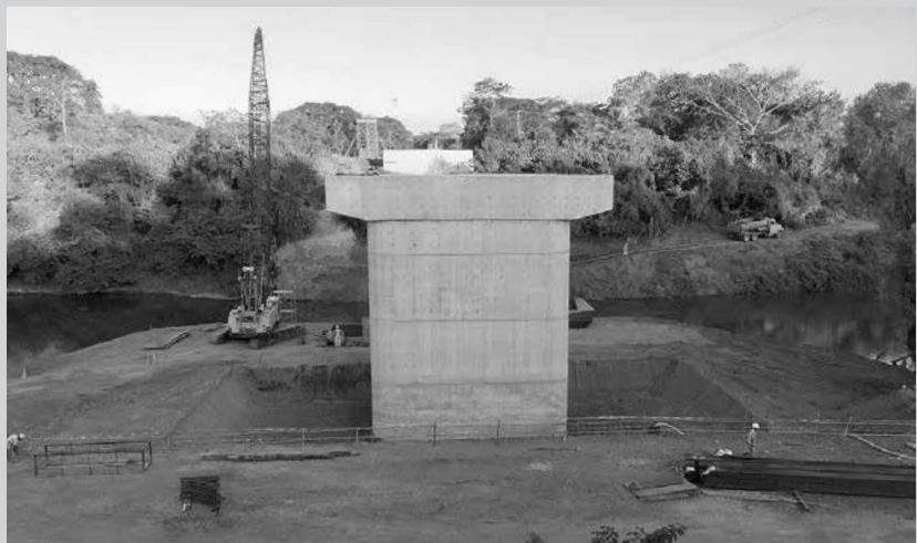
El puente “Paso Real”, el número 25 que se va a construir por la cooperación japonesa.
