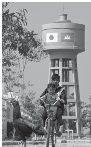
Camboya: Una torre de agua gestionada por la Autoridad para el suministro de agua de Siem Riep bajo el Proyecto de construcción de capacidades para el sistema de suministro de agua [fotografía de Kenshiro Imamura]
