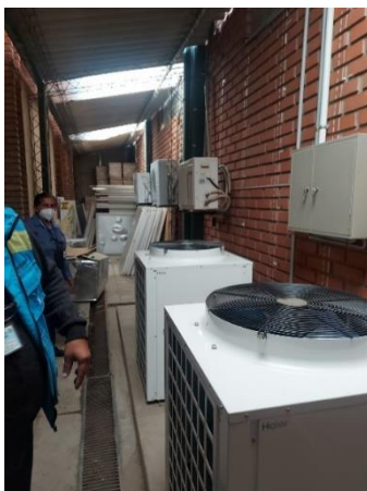
Personal a cargo de la cadena de frío utilizando EPP para ingreso a la cámara fría. Lavabo para limpieza de manos.
