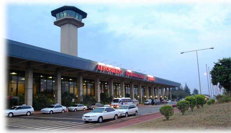
Construcción del Aeropuerto de Ciudad del Este
