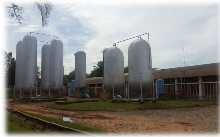
Mejoramiento de Suministro de Agua Potable en Asunción
