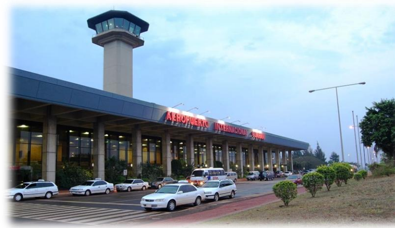
Construcción del Aeropuerto de Ciudad del Este
