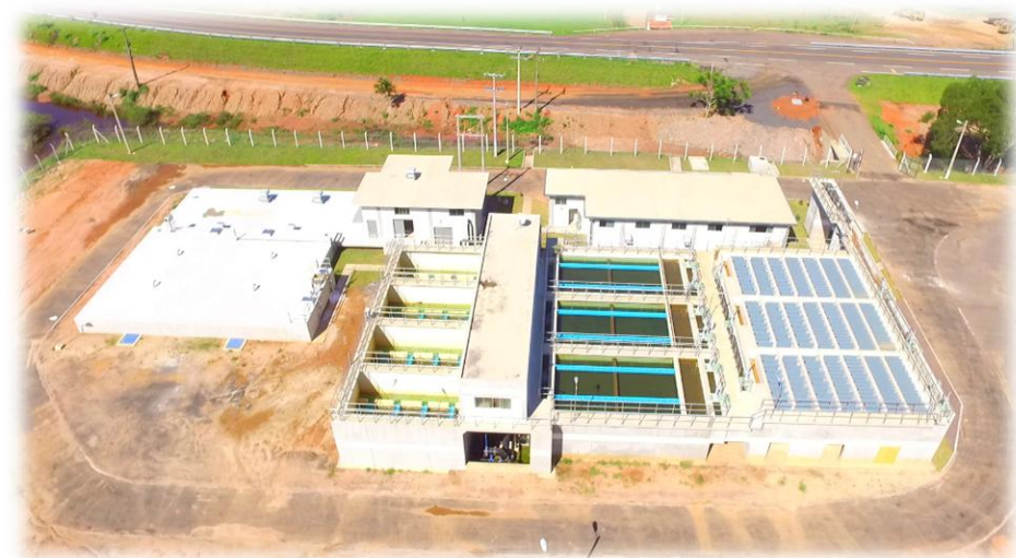
Planta Potabilizadora de Coronel Oviedo
