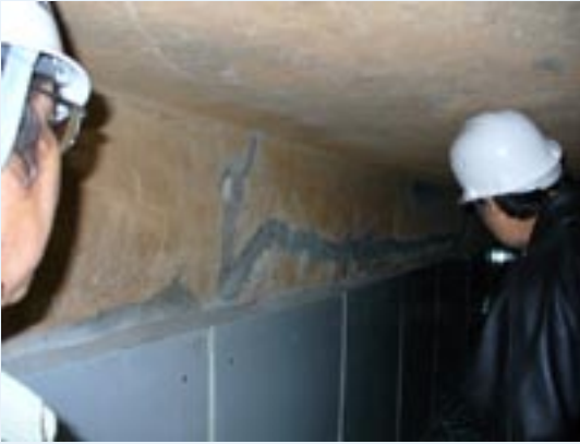
السيد ناغاساوا الممثل المقيم للوكالة يستطلع الأعمال المنفذة من إكساء بألواح البلاستيك المسلح، وإصلاح لأحد الشقوق
