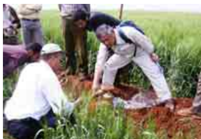
灌漑施設の現場での調整
