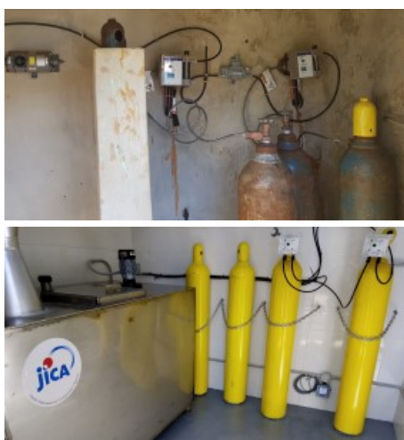
写真①: 改修前(写真上)と改修後(同下)のQaa Water Station
