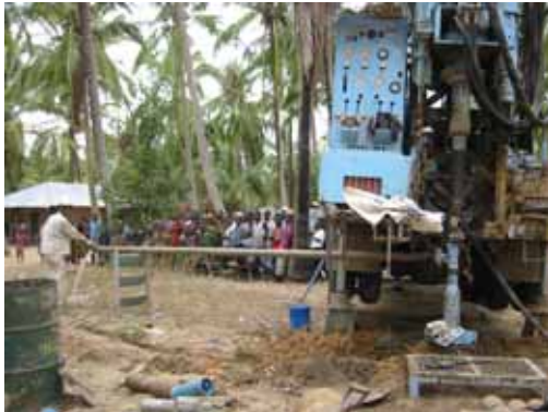
村落で実施中の掘削作業
