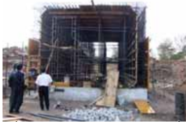
道路横断排水施設の改修
