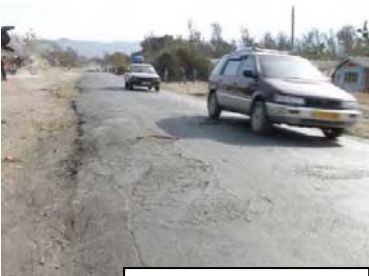
改修前の道路の状況
