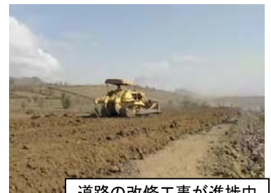
道路の改修工事が進捗中
