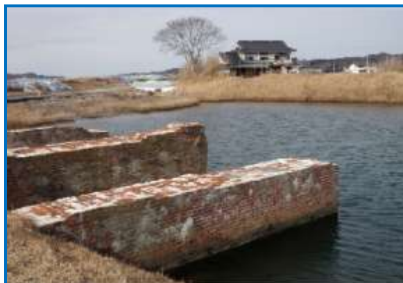
近代港整備の野蒜築港跡の煉瓦積み
