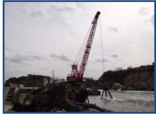
重機による海中の清掃
