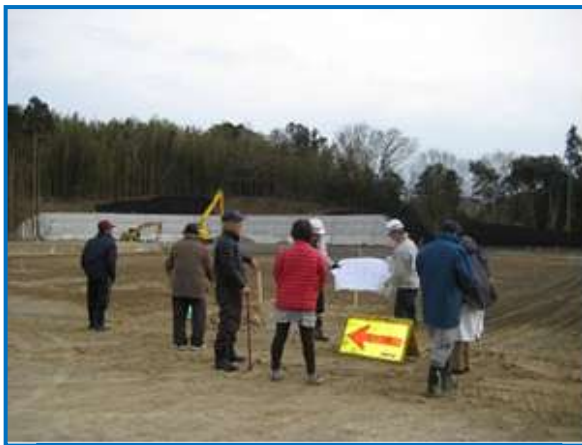
造成中の高台移転地見学会
