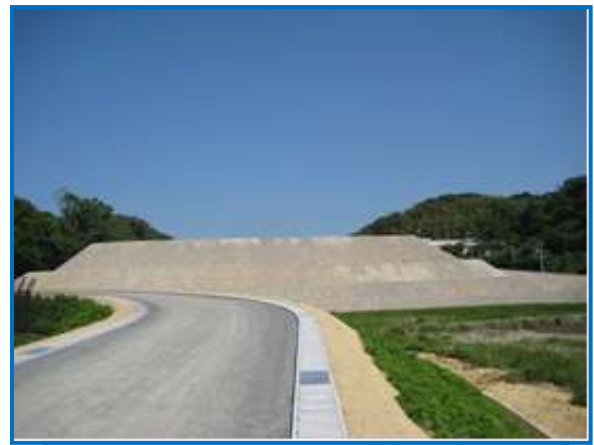
完成間近の高台造成地
