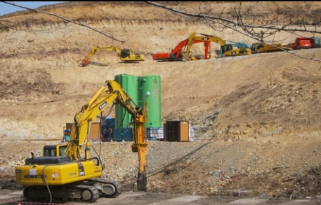
地盤改良工事が進む野蒜地区北部丘陵地区
