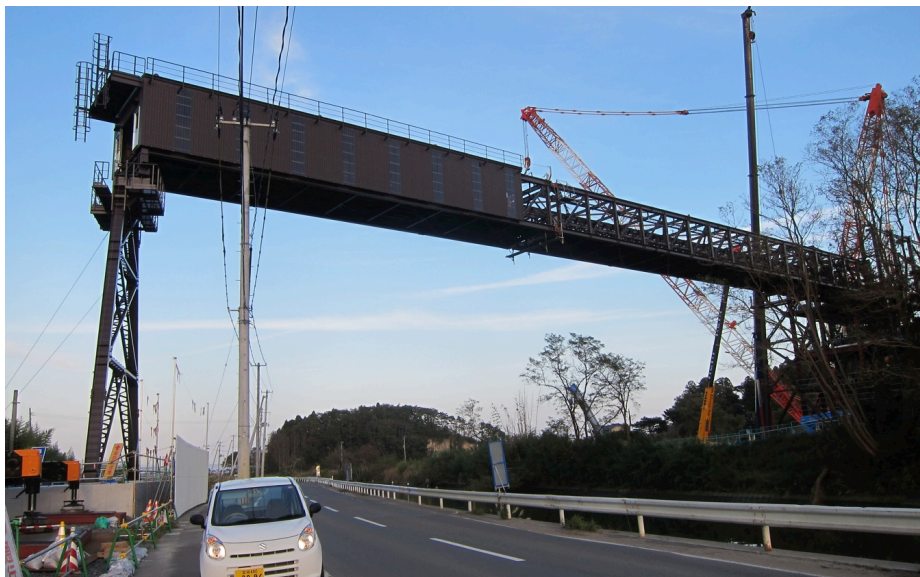
高台造成地の土砂を運搬するため、運河をまたぐベルトコンベアを建設中の東名運河
