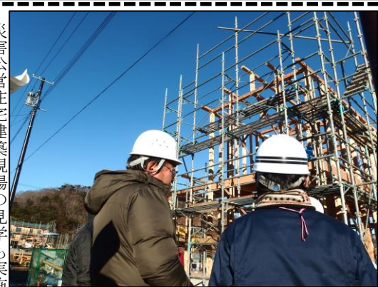
災害公営住宅建築現場の見学も実施
