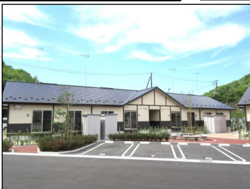
▶完成間近の災害公営住宅(野蒜ヶ丘三丁目・低層集合タイプ)
