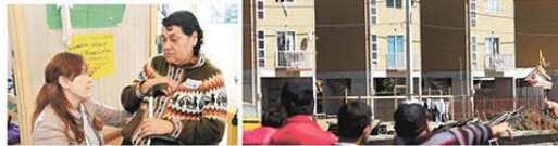
津波で壊れた住宅には、1階が土間と土間に合わせた2階建ての復興住宅が建設された。
