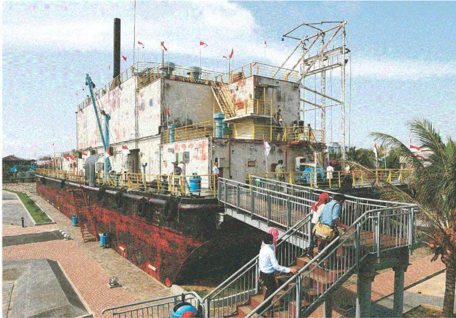
津波で500m内陸に打ち上げられた発電船。現在は視察員や観光客のために公園として整備されている。バンダアチェ（写真部・佐々木浩明撮影）
