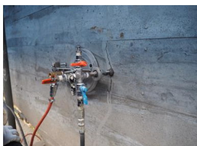
圧力調整注入 工法による補修 施工
