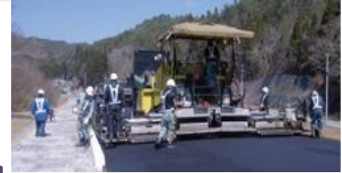
再生アスファルトを活用した舗装
